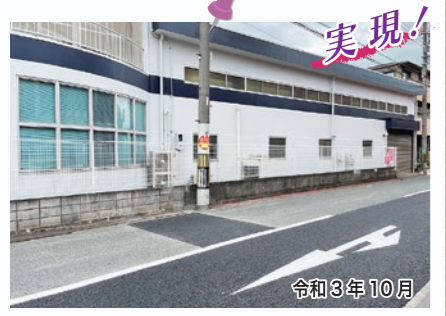
実現! 松原市大堀2-20-39付近 大阪府の道路整備工事仮復旧処理に段差が生じ、車が通る振動が周辺の会社に響くため、再整備をさせていただきました。 令和3年10月
