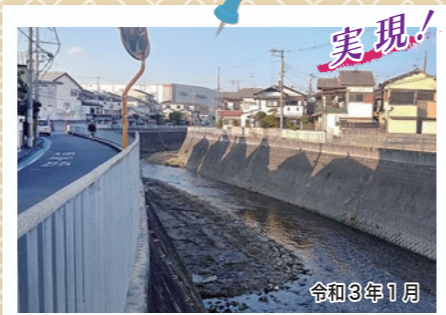
実現! 東除川河道の整備と樹木伐採を推進させていただきました。 令和3年1月
