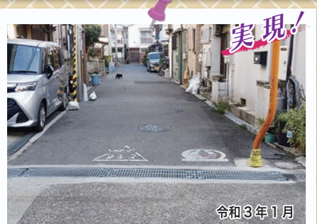
実現! 天美東5-3-6付近 グレーチングの整備をさせていただきました。 令和3年1月
