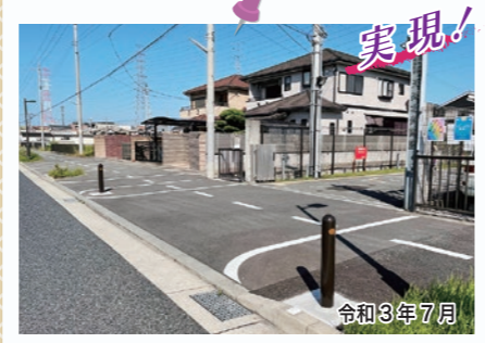
実現! 松原市天美北1-360-1前 昨年、天美北保育園に車が突っ込む事故が発生し、大阪府、松原市と協議をさせていただき、子どもの安全確保のため保育園前にポラードを3本設置させていただきました。 令和3年7月
