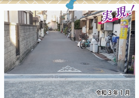
実現! 天美東5-3-7付近 グレーチングの整備をさせていただきました。 令和3年1月
