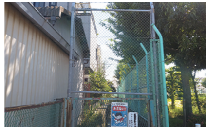
令和元年8月 一津屋東公園横側の防御柵に、子どもが乗り越えられないよう更に高くし、安全確保が保てるよう整備をさせていただきました。
