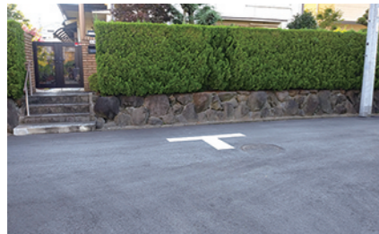
令和元年6月 市小川1-9-7前 安全確保のため交差点マークを標示させていただきました。
