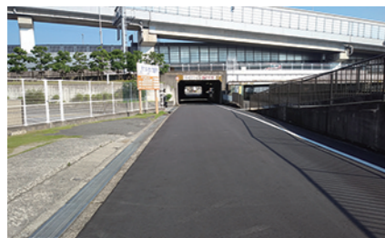
令和元年7月 大堀3-19-11付近 大堀上小橋から中央環状線高架下まで道路整備をさせていただきました。
