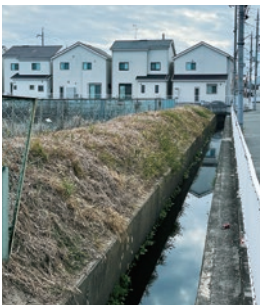
▲東新町1丁目 水路の草伐採
