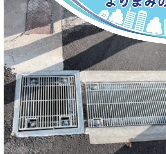
▲天美西2丁目 グレーチング設置
