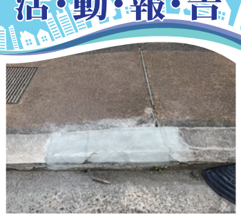
▲高見の里2丁目 歩道の修理
