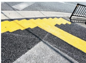
▲天美西3丁目 点字ブロック改修
