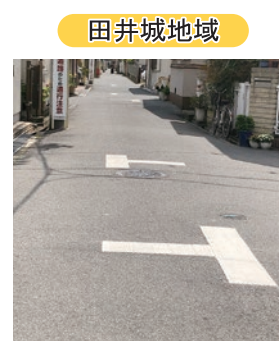
▲路面標示(7カ所)
