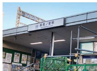
高見の里駅 エレベーター設置事業 (12月完成予定)
