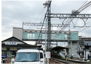
布忍駅 エレベーター完成 (10月29日)
