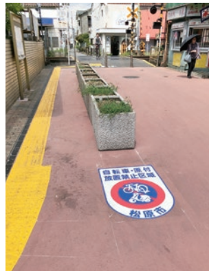
高見の里駅前の道路改修 (8月)
