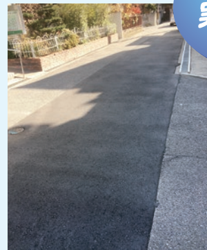
▲岡3丁目 道路改修
