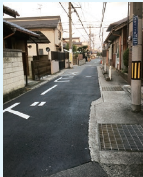
▲西野々1丁目 道路改修
