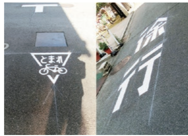
▲岡4丁目： 路面標示の整備
