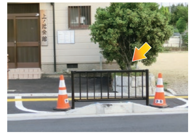
▲立部3丁目(上ノ池会館前)： 道路安全策の設置
