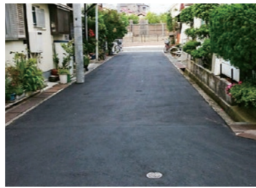
▲岡3丁目： 道路改修
