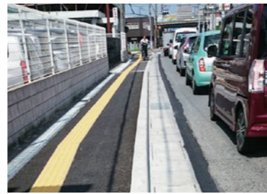
▲上田4丁目(塚大和高田線)： 歩道段差の改修
