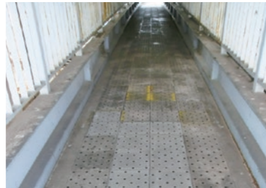
▲西大塚2丁目： 陸橋改修
