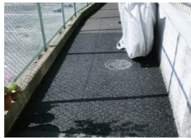
▲西大塚1丁目： 道路改修
