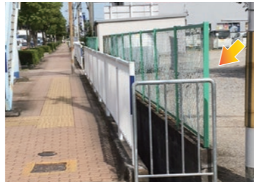
▲西大塚2丁目： 転落防止柵の設置
