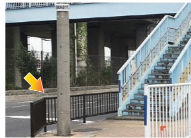
▲西大塚2丁目(中央環状線)： 道路防護柵の設置
