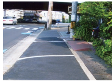
▲上田6丁目： 歩道改修
