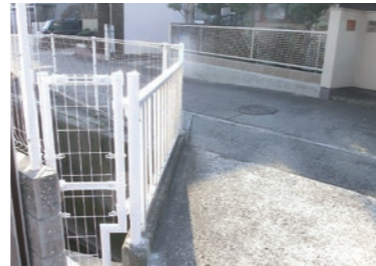
▲上田6丁目： 水路柵(開閉式)の設置
