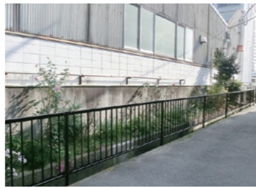
▲岡4丁目： 水路柵の設置
