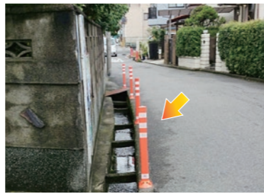
▲岡4丁目： 側溝転落防止ポールの設置
