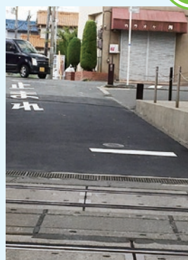
▲西野々1丁目 道路改修
