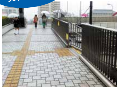
松原駅前 陸橋 傾斜床面の改修(滑り止め塗装)
